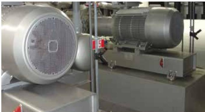
Die stufengeschalteten Verdichter mit Frequenzumformern für das Eisfeld: Jahrgang 2017. (Quelle: Iris Infanger)
