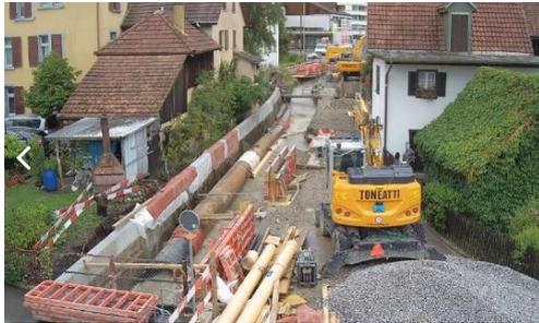
Im Frühjahr 2021 starteten die Bauarbeiten der zweiten Etappe für den hochwassersicheren Ausbau des Schäflibaches entlang der Bachstrasse, einschliesslich der Sanierung der Bachstrasse, der Neugestaltung des Muulaffeplatzes und der Gewässerraumfestlegung. Die erste Projektphase war geprägt von starken Hochwassern. Mittlerweile schreitet das Projekt aber zügig voran.
