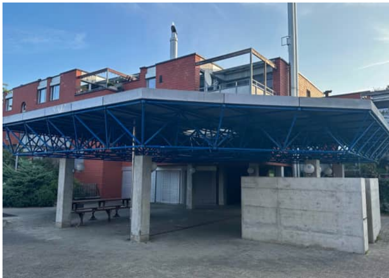
Abb. 28 Bestehende Überdachung im Wohnhof der 1. Etappe
