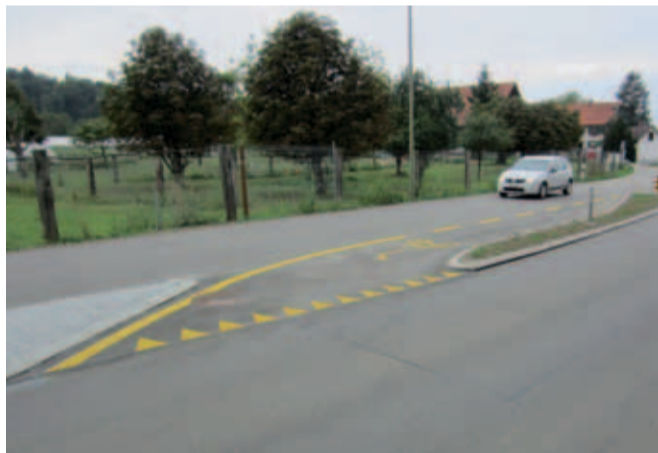
Velo-Linksabbiegespur an der Birmensdorferstrasse.
