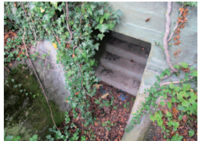
Eingang zum Bunker "Weihermatt".
