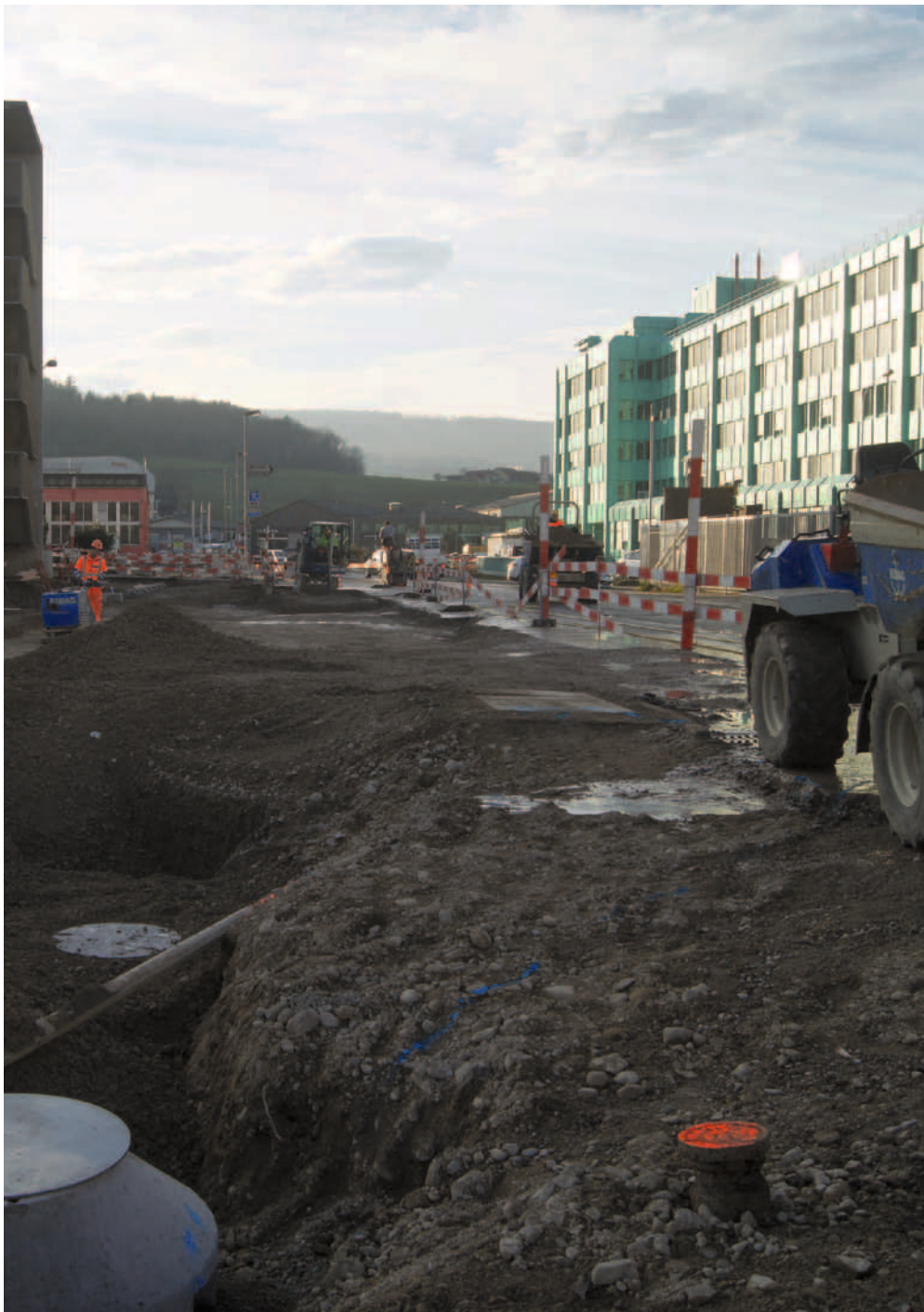
Baustelle "Urdorf Nord" - die Limmattalbahn nimmt Form an. Foto: Christian Murer
