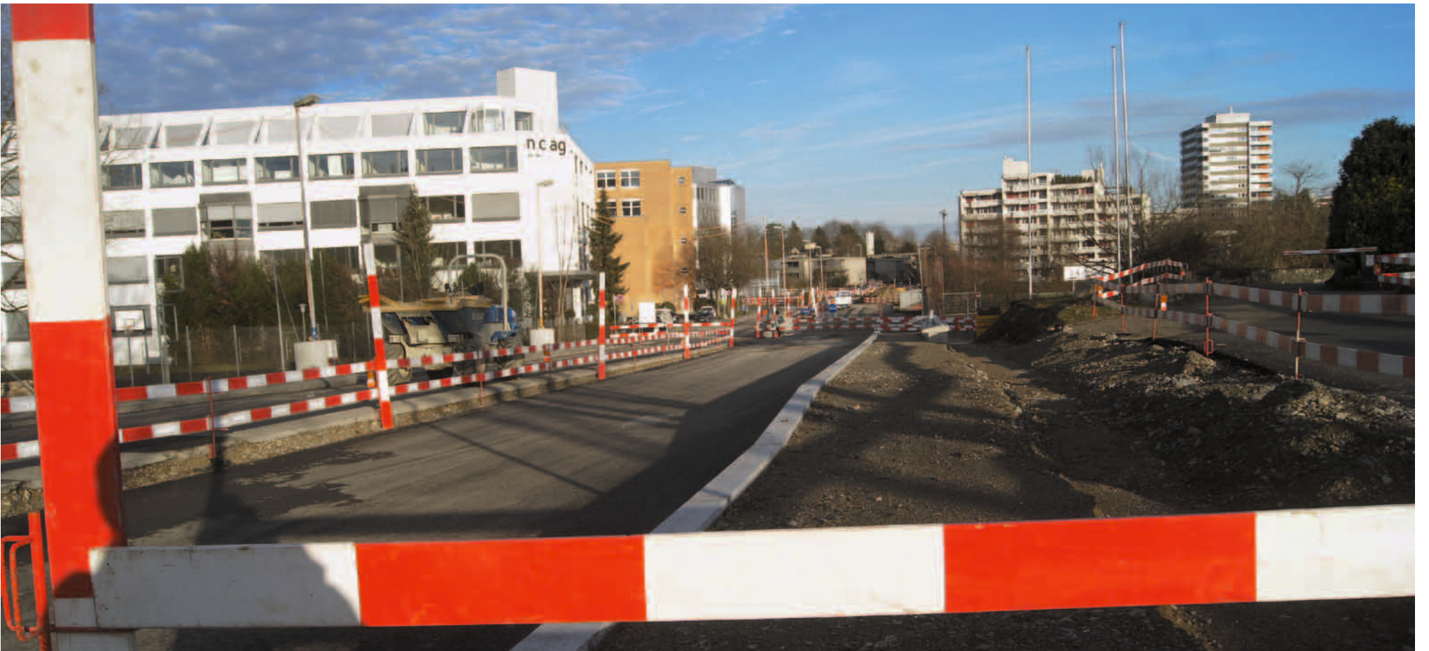
Baustelle "Urdorf-Nord" – Rot und Weiss dominiert den Wirtschaftsraum · Foto: Christian Murer
