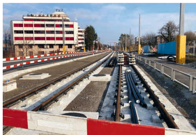
Die neuen Gleise der Limmattalbahn in der Luberzen.
