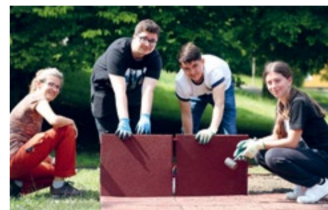
Die Fallschutzplatten wurden in Teamarbeit verlegt – Irene Nussbaumer, Giuseppe Perugini, Blendon Elshani und Fiona Kastrati (v.l.n.r.).
