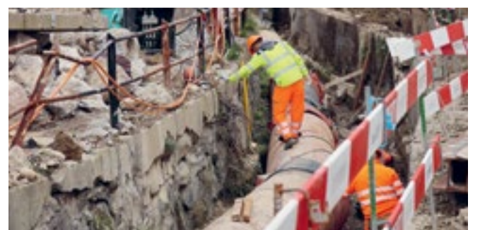
Der Schäflibach wird im Bereich der Baustelle in Röhren «verbannt», damit die Bauarbeiten möglichst im Trockenen erfolgen können.
