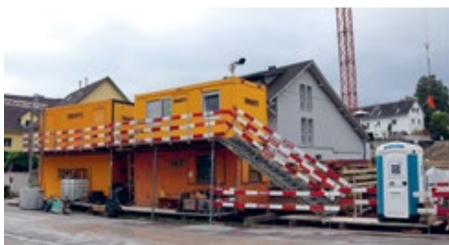
Arbeiten auf engstem Raum heisst, jeden Raum nutzen: Mannschaftscontainer auf einer Plattform über dem Bach.
