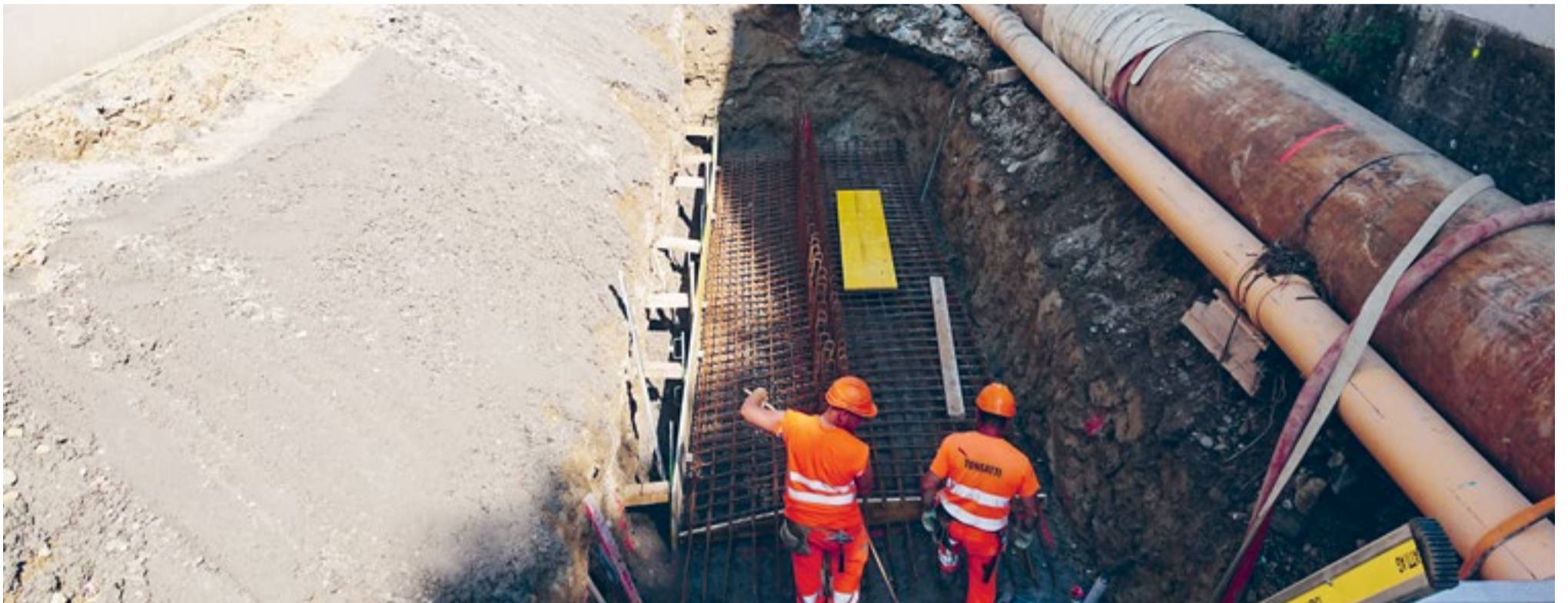
Tiefbauarbeiten an der Bachstrasse: Arbeiten auf engstem Raum.
