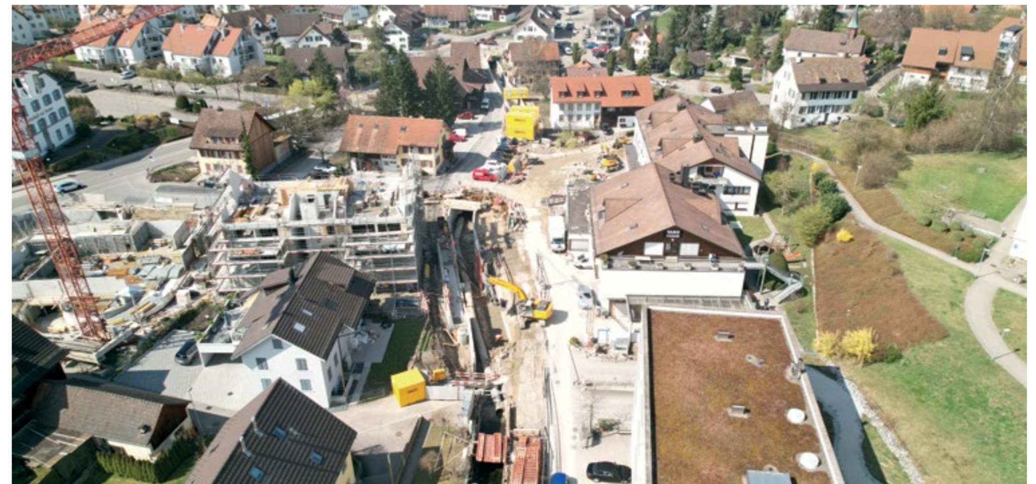
Baustelle «Bachstrasse»: Vogelperspektive Bauperimeter April 2022. Foto: Werkabteilung
