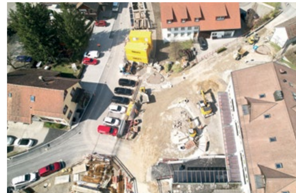
Baustelle «Bachstrasse»: Umbauarbeiten am Muulaffeplatz. Foto: Werkabteilung
