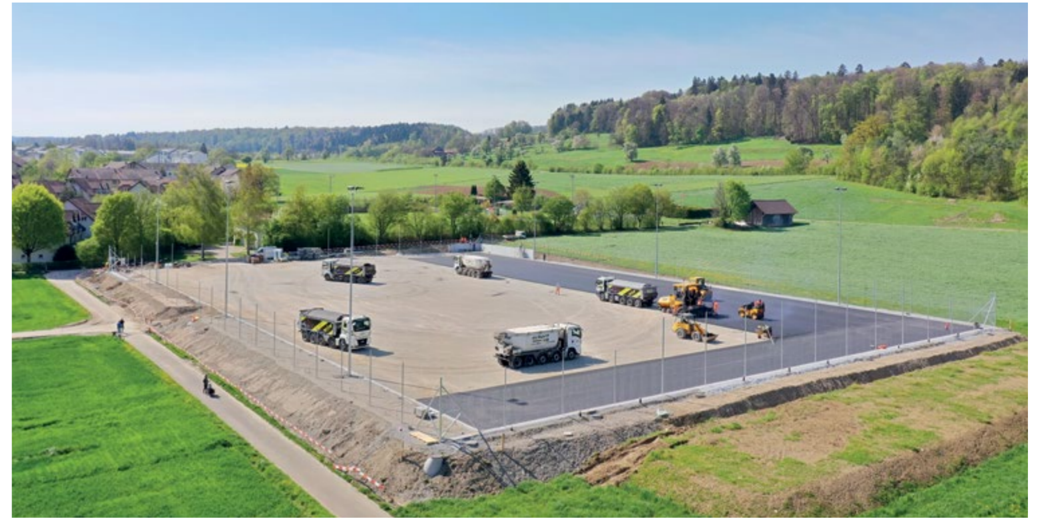
Baustelle «Kunstrasenfußballplatz»: Einbau Drainaspalt am 20. April 2022 (wasserdurchlässiger Spezialasphalt für den Kunstrasenaufbau). Foto: zvg
