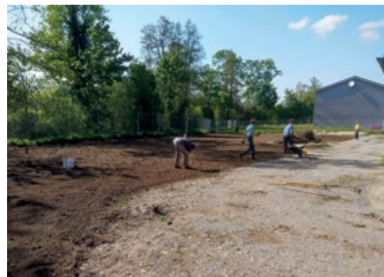
Wasen (Grasschicht) wurde bereits abgetragen, Nachbesserungen sollen den Boden möglichst gut für die Einsaat vorbereiten.
