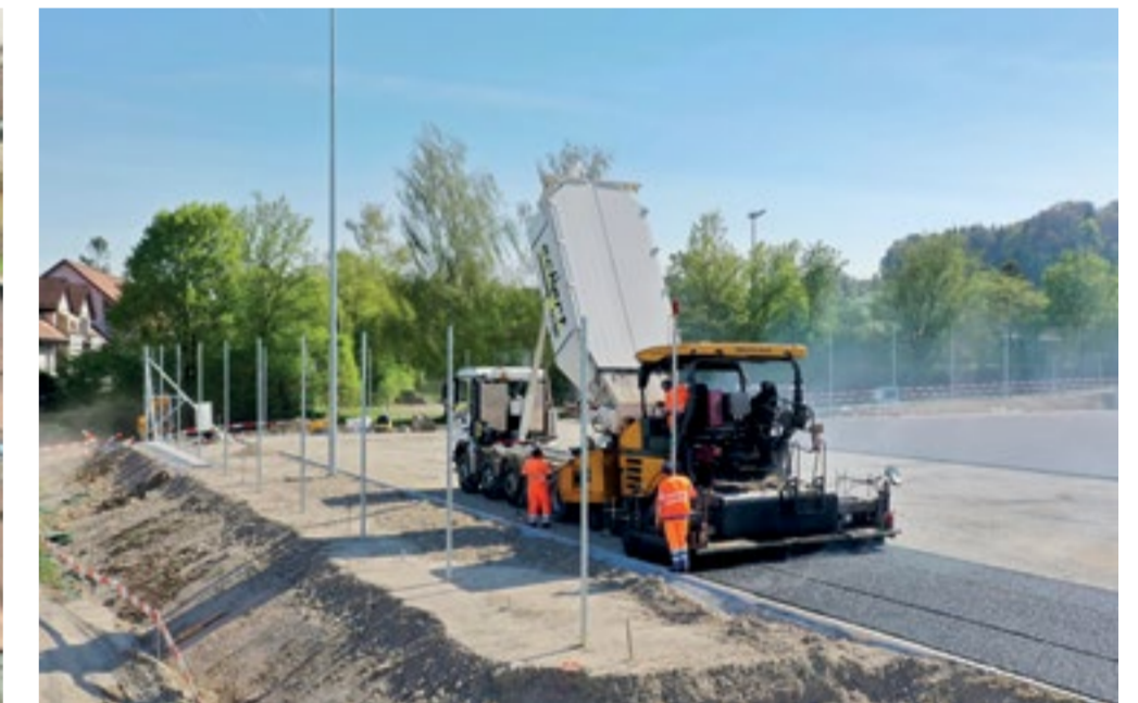
Baustelle «Kunstrasenfußballplatz»: Belagseinbau im April 2022. Foto: zvg
