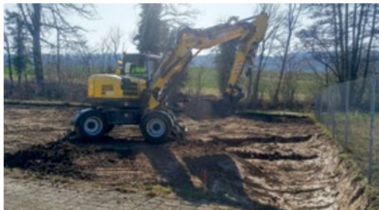
Aushub des Bodens, ca. 80 cm, für Steinstruktur. Ebenfalls wurden ca. 20 bis 40 cm Boden für die Sandlinie entlang des bestehenden Zaunes ausgehoben.
