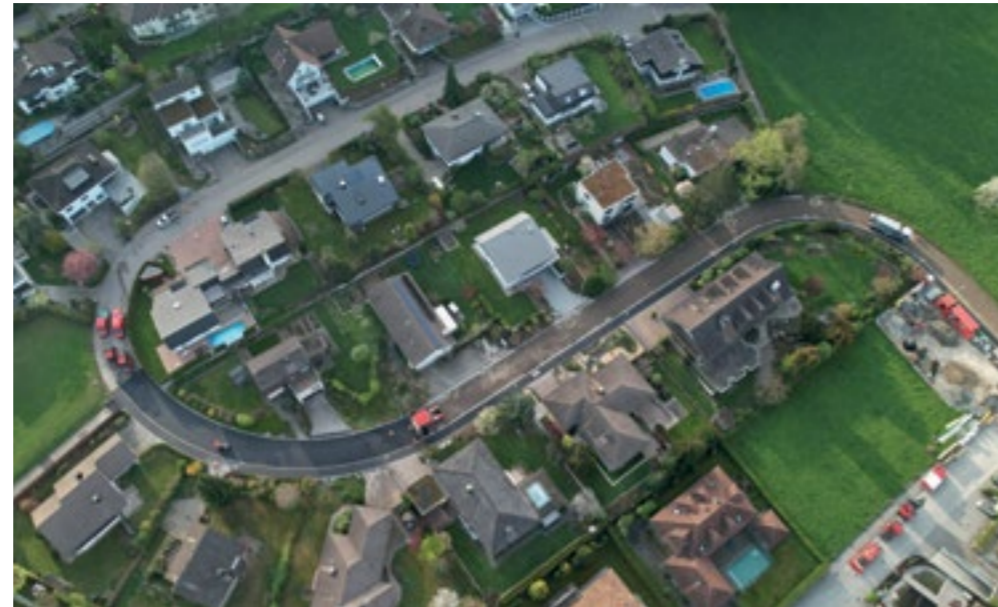
Baustelle «In der Rebhalden/Im Grü»: Belagseinbau In der Rebhalden im April 2022. Foto: Werkabteilung
