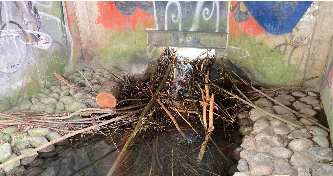
Biberdamm beim Hochwasserrückhaltebecken Allmend.
