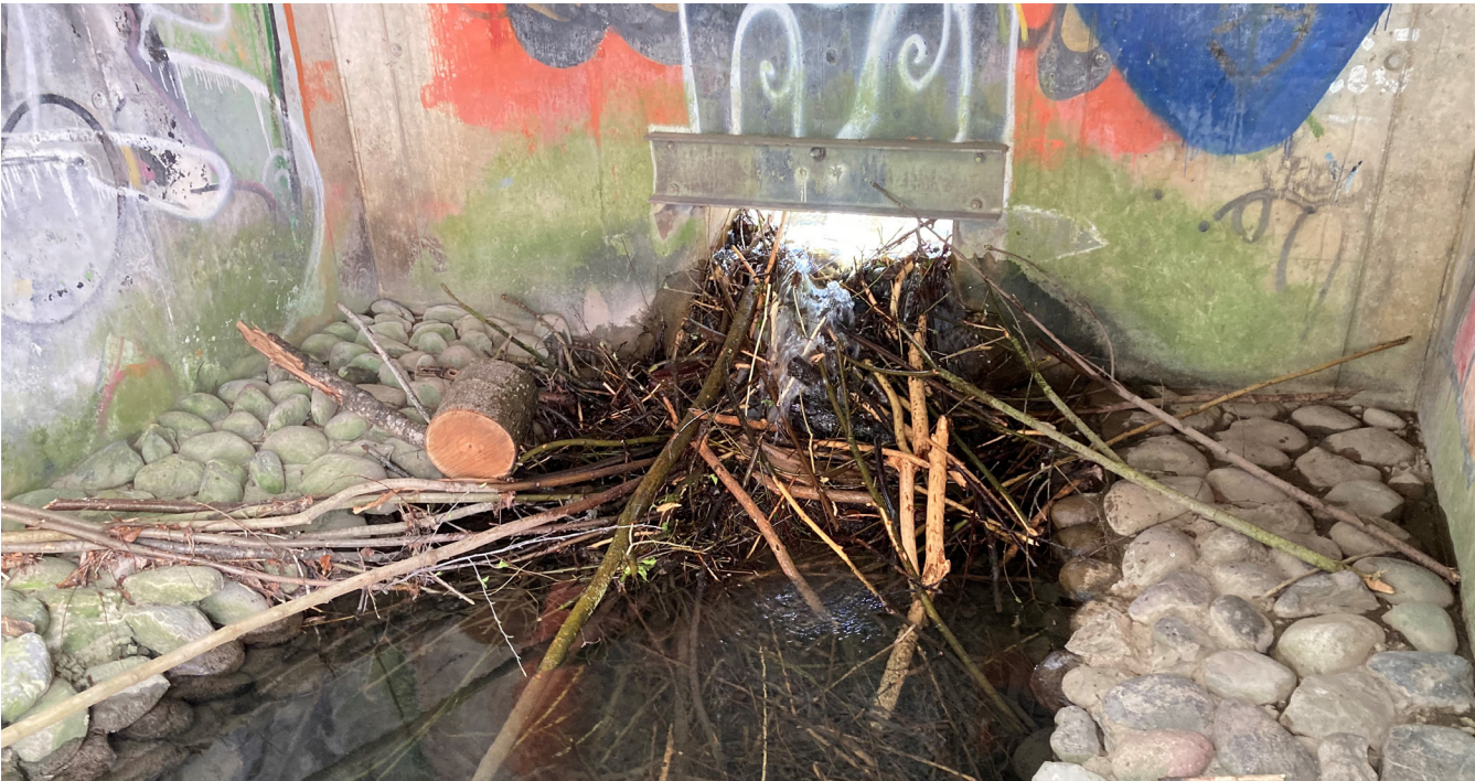
Biberdamm beim Hochwasserrückhaltebecken Allmend.
