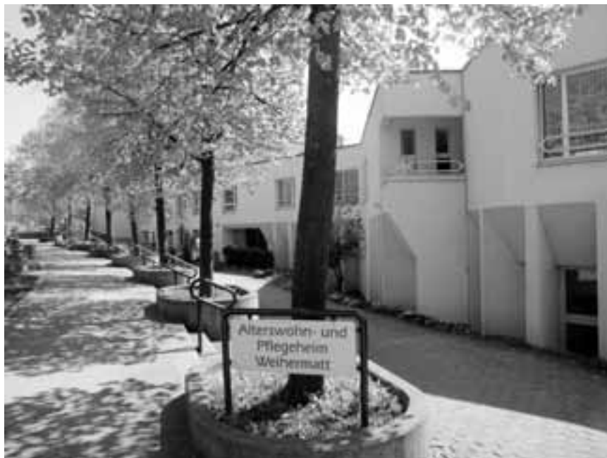
Dem Alterszentrum Weihermatt stehen umfassende bauliche Erneuerungen bevor
