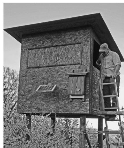
Montage eines Flachkastens an einer Jagdkanzel.
