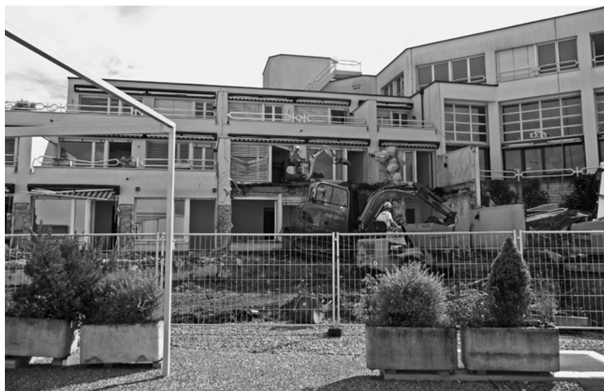
Die Bauarbeiten am alten Gebäude des Alterszentrums Weihermatt sind in vollem Gange.
