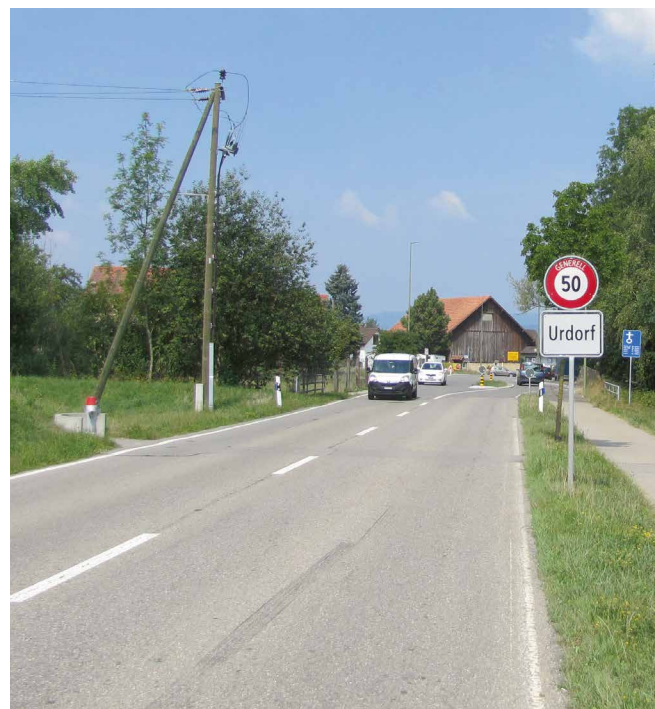
Südliche Ortseinfahrt Urdorf
