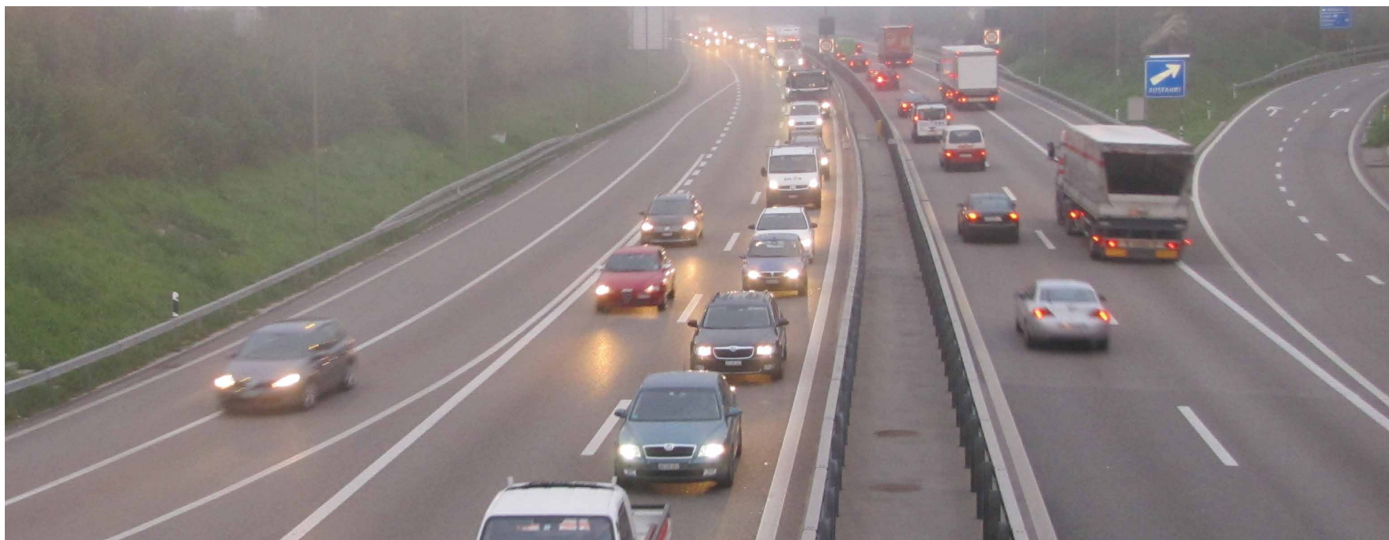
Seit der Eröffnung der Westumfahrung ist die Lärmbelastung durch die Autobahn in Urdorf gross - Alle Fotos: zvg
