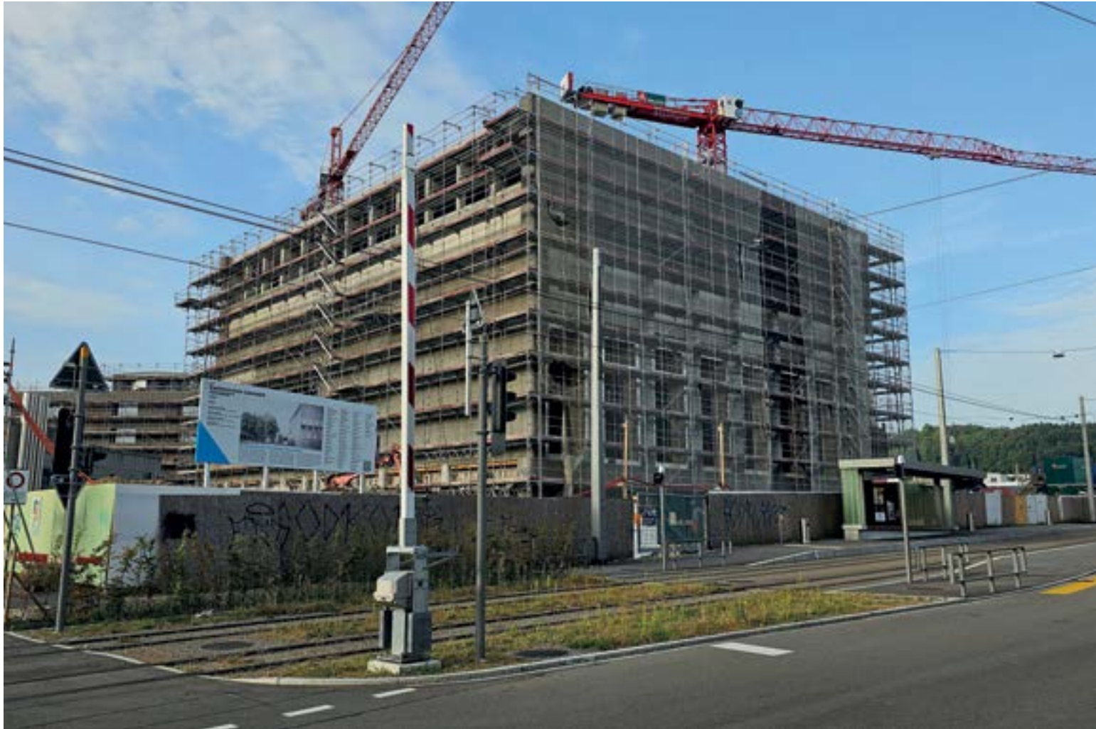
Der Stand der Bauarbeiten im August 2023.
