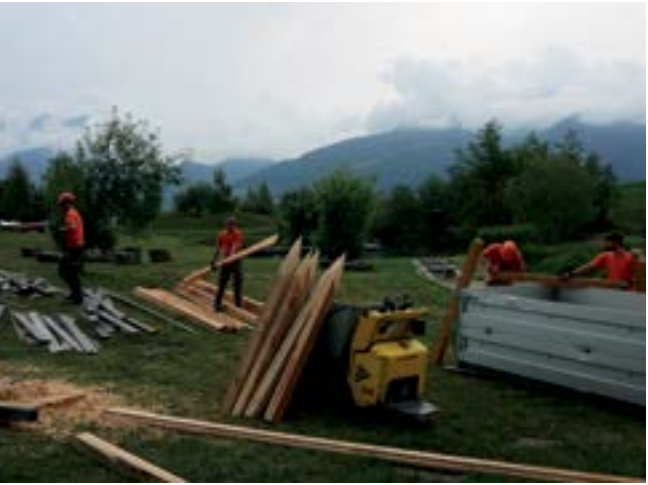
Die Zivilschützer beim Vorbereiten der Pfosten und Latten für den neuen Holzzaun.
