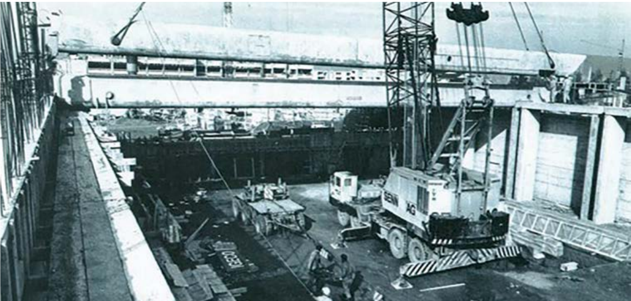
Start der Bauarbeiten der Mehrzweckhalle Zentrum Anfang Juli 1971. Foto: zvg
